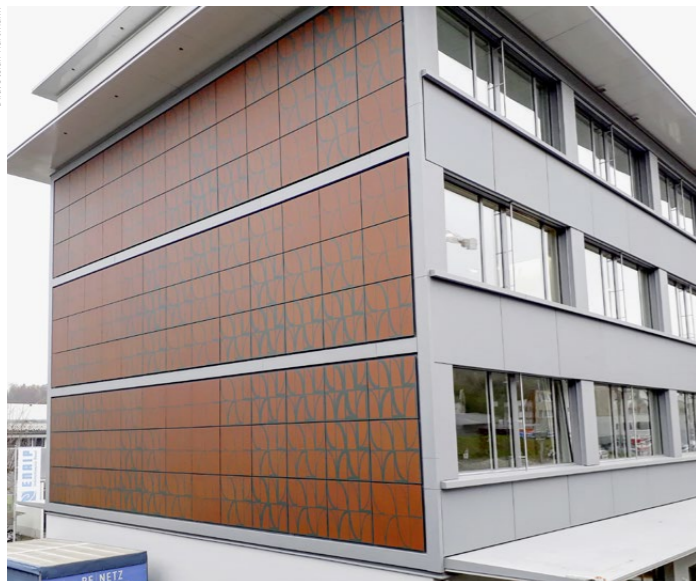
Die künstlerischen Elemente an der Westfassade dienen auch der Solarstromerzeugung (links). Und selbst die Fenster im Treppenhaus des Anbaus dienen der Energieerzeugung (rechts).
