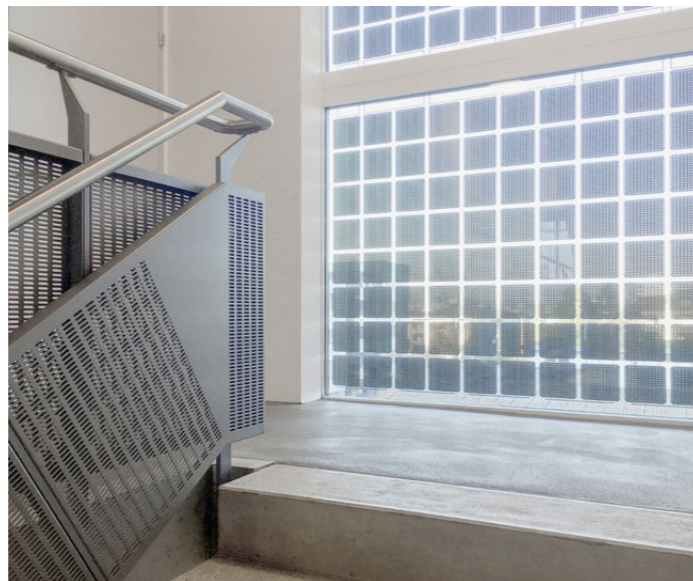
Die künstlerischen Elemente an der Westfassade dienen auch der Solarstromerzeugung (links). Und selbst die Fenster im Treppenhaus des Anbaus dienen der Energieerzeugung (rechts).
